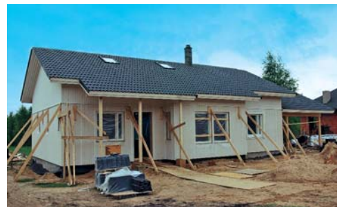
Po długim majowym weekendzie dom pokrywa dachówka, a wewnątrz trwają prace wykończeniowe – 15 maja
