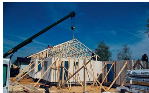
Stawianie dźwigarów dachowych – 30 kwietnia
