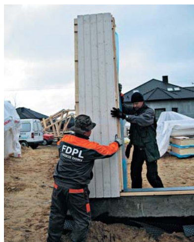
Pierwszy moduł na fundamentie – 26 kwietnia przed południem
